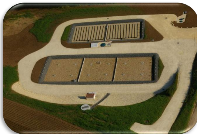
Station de St Ciers du Taillon 390 EH de type filtres plantés de roseaux
