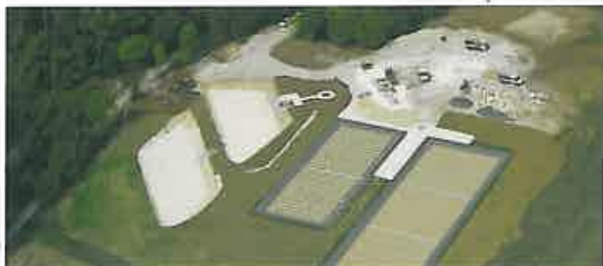
LANDRAIS « lits plantés de roseaux » 300 équivalent habitants Montant de l'opération 315 000 € HT
