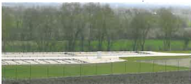
GENOUILLÉ « lits plantés de roseaux » 610 équivalent habitants Montant opération : 480 000 € HT
