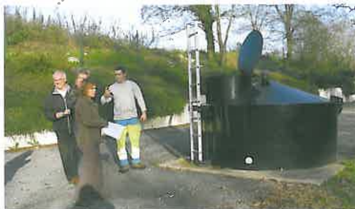
Inspection du captage de ST BRIS DES BOIS par l'ARS en Novembre 2010
