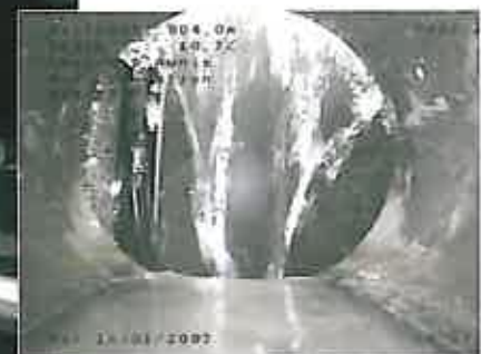
Perforation et pénétration d'eau
