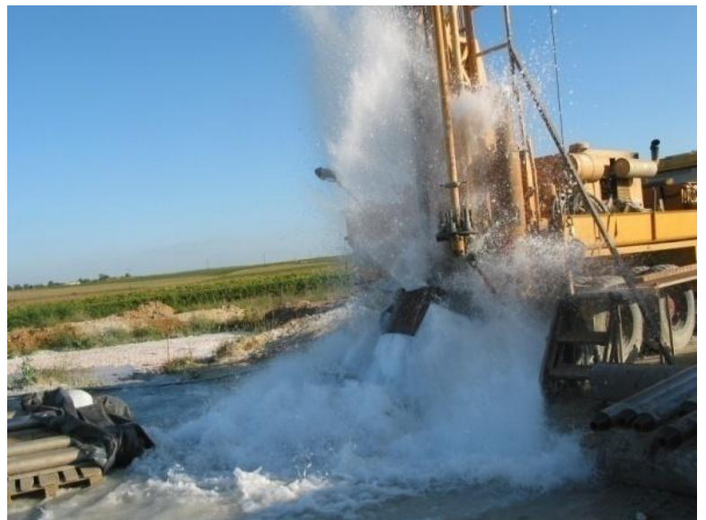
Foration de la partie captée pour l'eau potable
