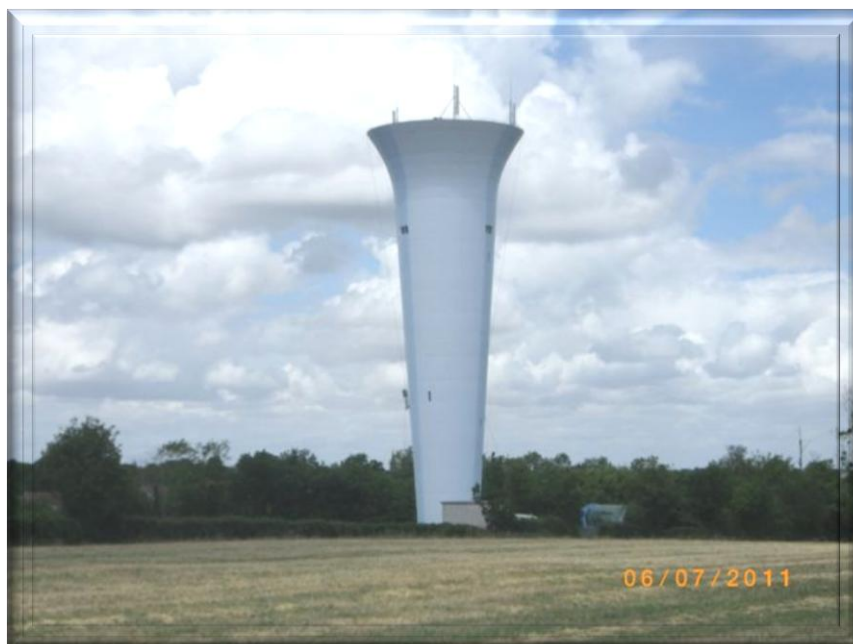
Château d'eau de PORT D'ENVAUX
