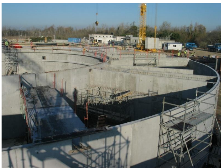
Construction d'un des deux ouvrages combiné
